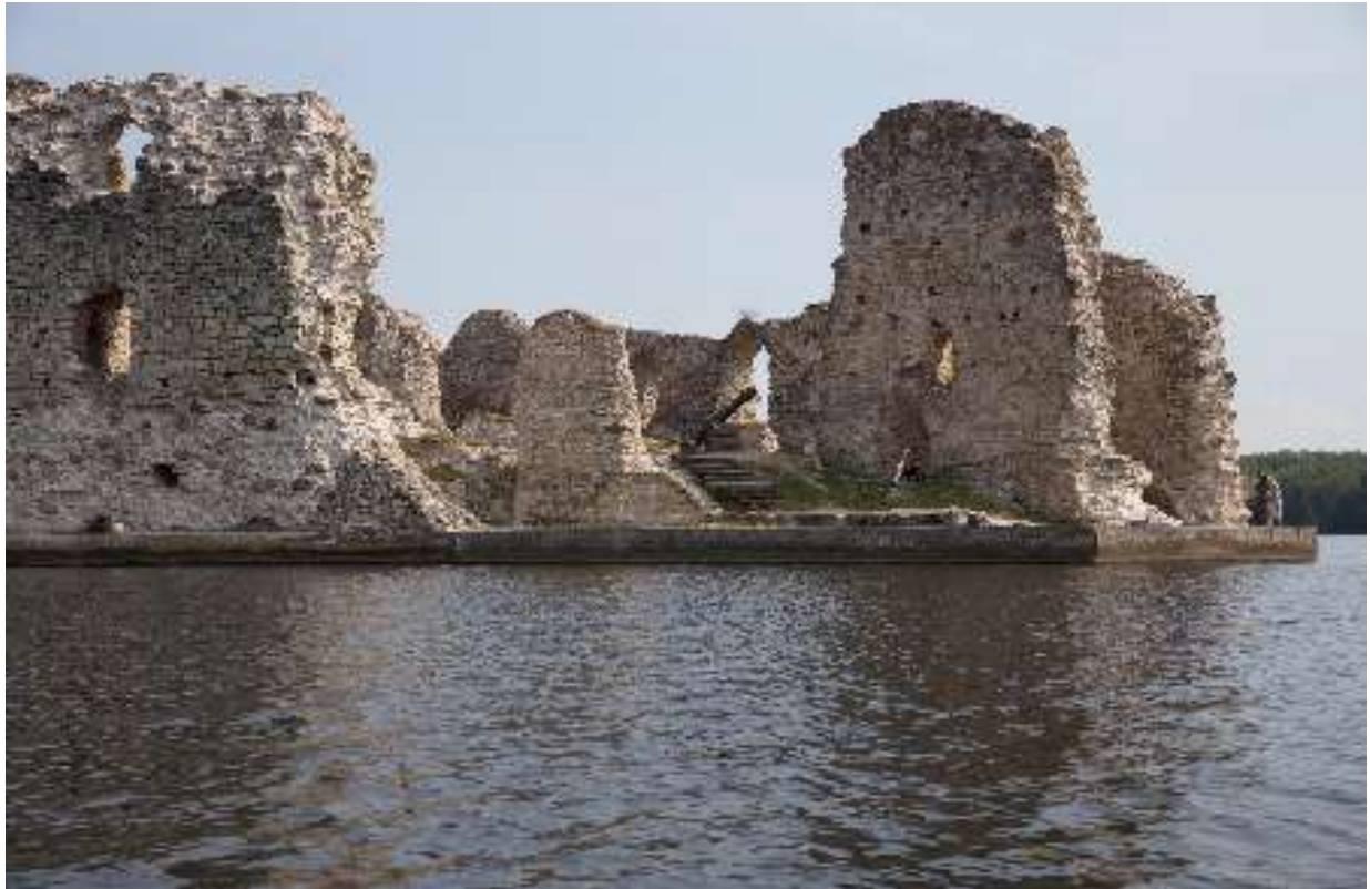
3.fotoattēls. Skats uz pilsdrupām no ziemeļu puses. Ārsienās vērojami mūra čaulas zudumi, kā arī atsevišķi akmeņi vai ķieģeļi, kuriem zudis konstruktīvais balsts. Daļa iekšsienu virsmas plaknes iesegtas ar velēnu.
