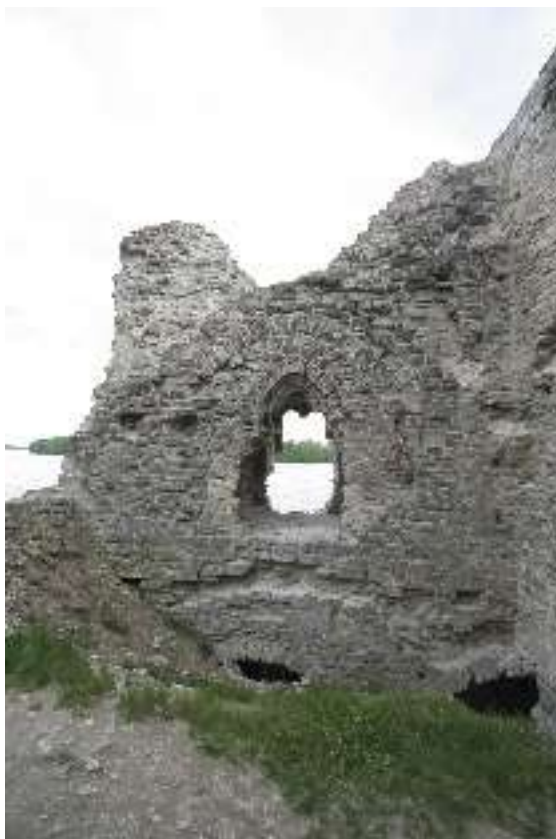
5.fotoattēls. Skats uz pilsdrupu dienvidu puses sienas austrumu galu no pagalma puses. Pagrabstāva līmenī redzamas esošo šaujamlūku ailu augšējās daļas. Ārsienā vērojami lokāli šuvējuma zudumi.
