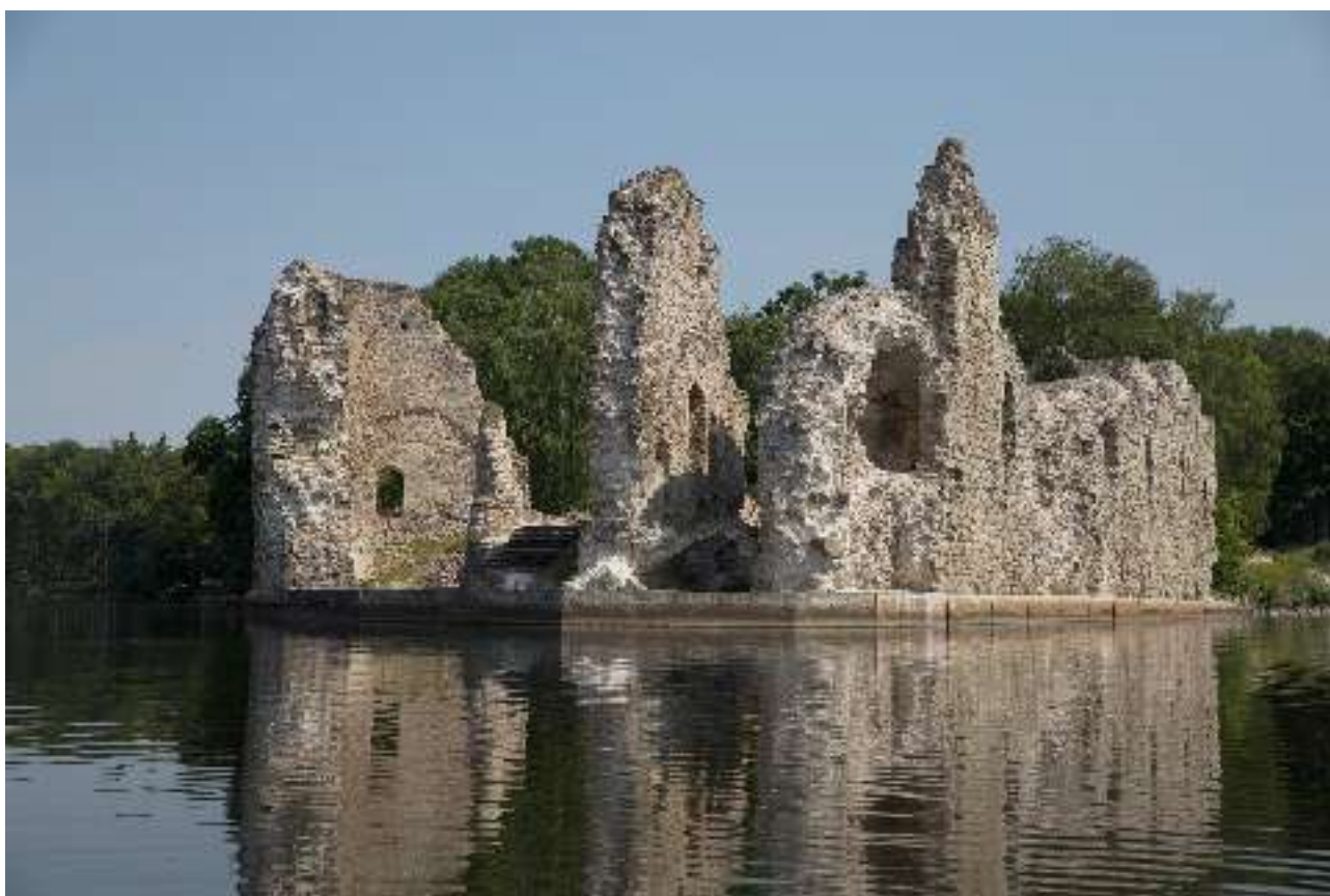
2.fotoattēls. Pilsdrupu kopskats no rietumu puses. Esošo ārsienu apakšējās daļas (virs zemes esošās) apbetonētas.
