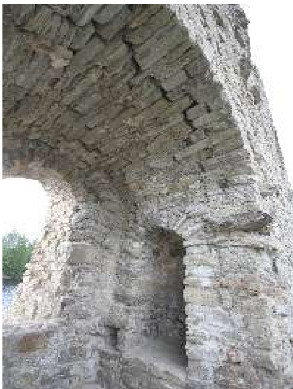
6.fotoattēls. Skats uz ziemeļu ārsienu no pagalma puses. Plaisas un izdrupis šuvējums logailu arkveida pārsedzēs.
