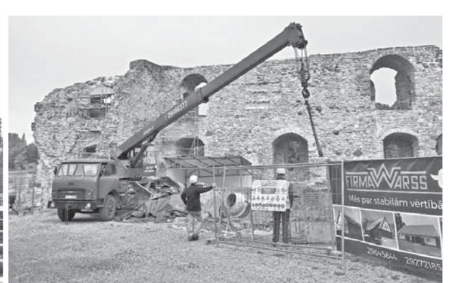
Šajā vasarā noritēja pilsdrupu mūru ārējās sienas konservācijas un nostiprināšanas darbi.
