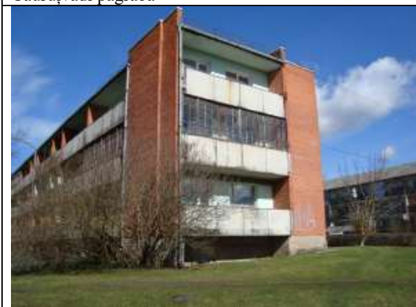
Ēkas fasādes ar lodžijām
